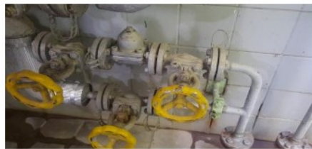
Imagem 06: Dreno do trocador de Calor - Unidade 07
