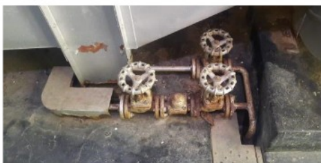
Imagem 07: Dreno do radiador 01 – Linha de Secagem
