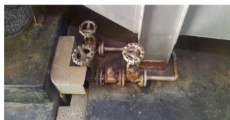
Imagem 08: Dreno do radiador 02 – Linha de Secagem
