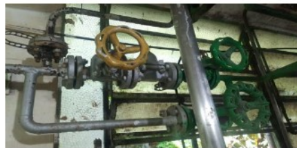
Imagem 04: Dreno inferior reator – Unidade 07
